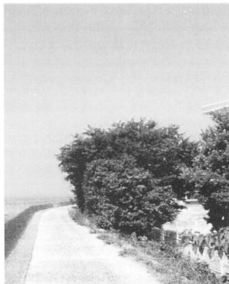
写真1: 調査地点①付近
