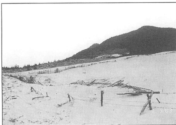
寫眞 12: 堆砂垣による飛砂堆積(遠景)
