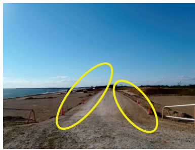
機械盛土工との境に暗渠工(栗石)を施工
