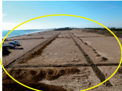
砂丘造成盛土工との境に暗渠工(栗石)を施工
