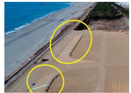
天端(5%勾配)の路肩に側溝(栗石)と法面に土のう水路を施工
