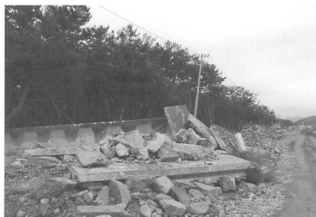
写真2：海岸林縁部（海側）に堆積した瓦礫（2011.8.23撮影）
