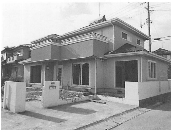
写真4: 追跡調査で取り壊されていた家屋 (窓(1F)破損) (2011.8.24撮影)
