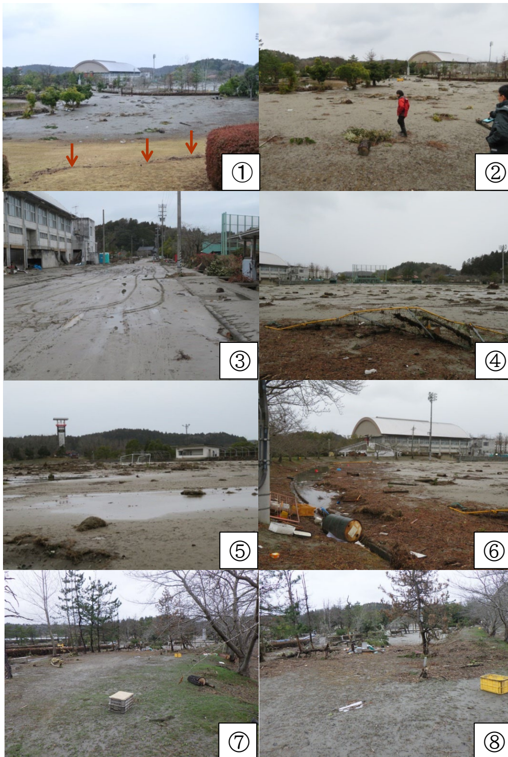
①侵入した津波は芝生広場で停滞し、大量の泥が堆積した。手前に侵入ラインが見える。 ②公園内に侵入した津波は芝生広場で停滞し、漂流物が残った。 ③津波は親水護岸を乗り越えて体育館前の道路内陸側へ進んでいったと思われる。 ④⑤体育館前・裏のグラウンドにも侵入し、大量の泥と漂流物を運んできた。 ⑥公園内のグラウンド縁には津波の洗堀により水たまりができた。 ⑦⑧津波の後には多くの漂流物が残されていた。
