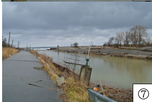
①～⑧ 輪島市町野町町野川河口付近の堤防護岸及びアスファルト舗装路面の破壊(山地斜面にも多数の崩壊地が確認できた。)
