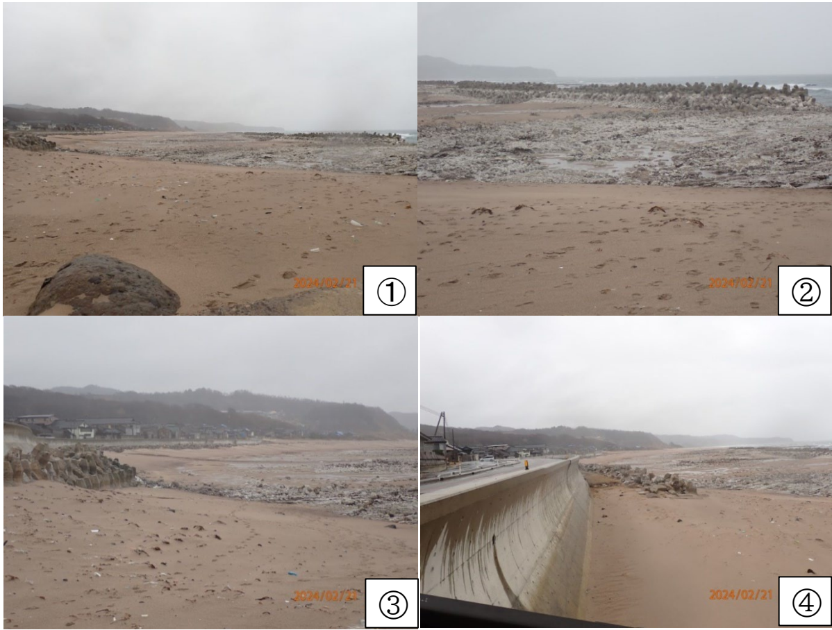
①②黒島漁港の南側海岸は離岸堤まで完全に陸化した。 ③④砂浜幅も変化し、浜の乾燥化により飛砂が増加する可能性あり。
