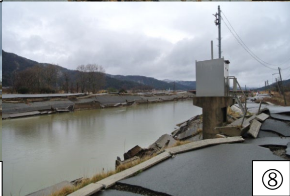
①～⑧ 輪島市町野町町野川河口付近の堤防護岸及びアスファルト舗装路面の破壊(山地斜面にも多数の崩壊地が確認できた。)
